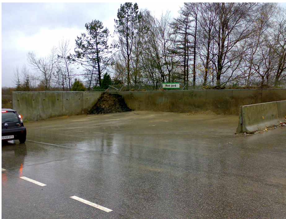
Billede nr. 1: Opbevaringspladsen på Birkegårdsvej er omkranset/afgrænset af betonstøttevægge på tre sider.
