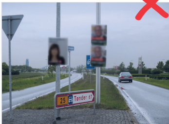
Ulovlig ophængning i midterrabat på motorvej - dækker også over autoriseret færdselstavle.
