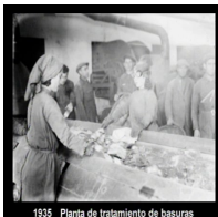
1935 Planta de tratamiento de basuras
