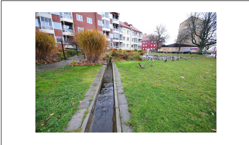
Figur 2.3 Eksempel på en kombination af åbne render og våde bassiner.
