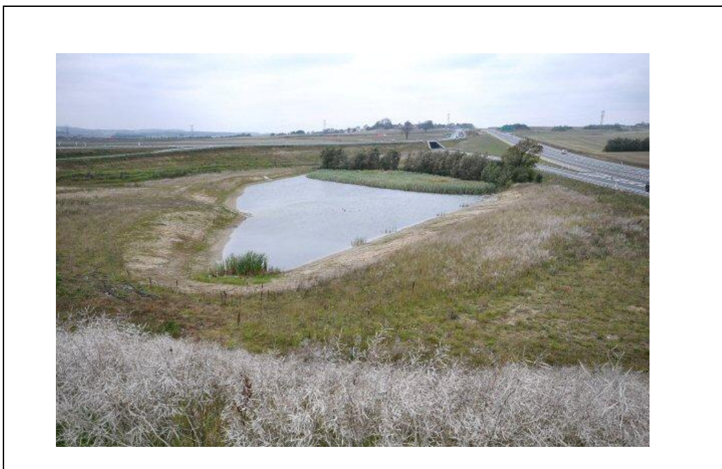
Figur 2.5 Eksempel på bassin med flade skrænter.
