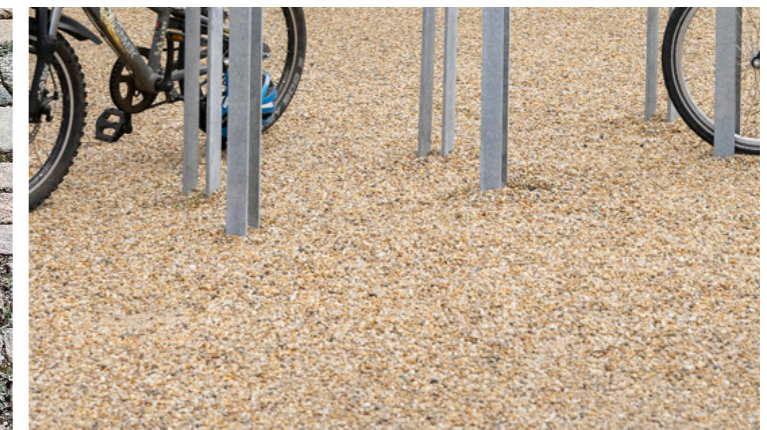
Brug af knust beton som grusoverflade i udvalgte områder
