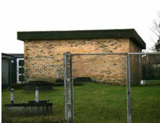
Fastrup Mark Vandværk, AnlægsID 80594
