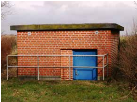
Lillering Vandværk, AnlægsID 80615
