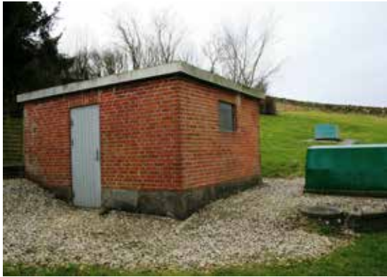
Todbjerg Vandværk, AnlægsID 80636
