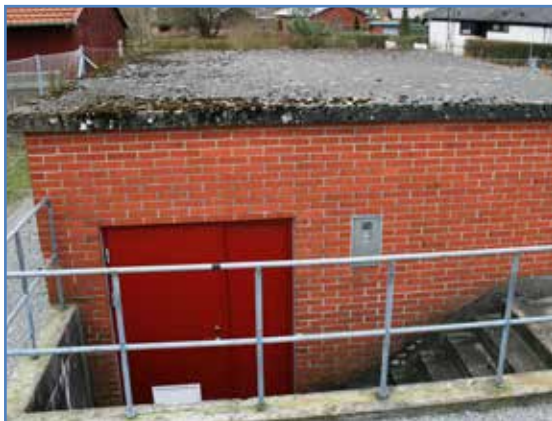
Mejlby Vandværk, Helbovej, AnlægsID 80621
