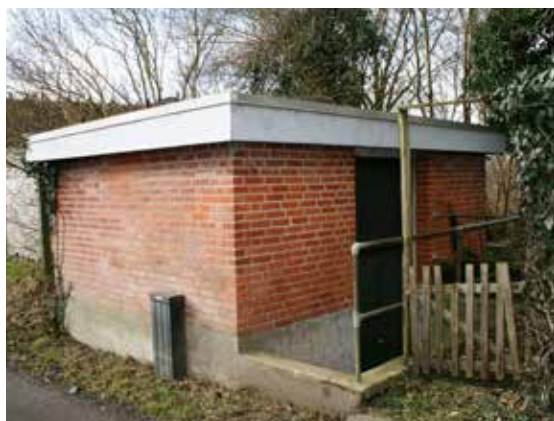
Hørslev Vandværk, AnlægsID 80610
