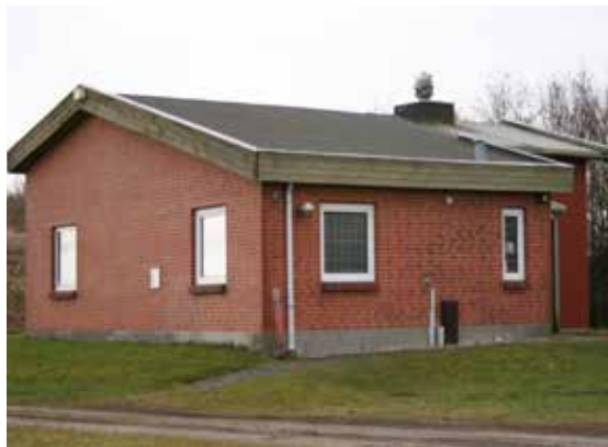
Egå Vandværk, AnlægsID 80592
