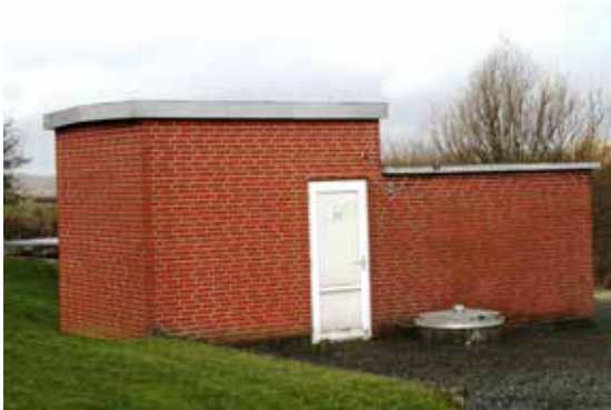
Tåstrup Vandværk, AnlægsID 80637
