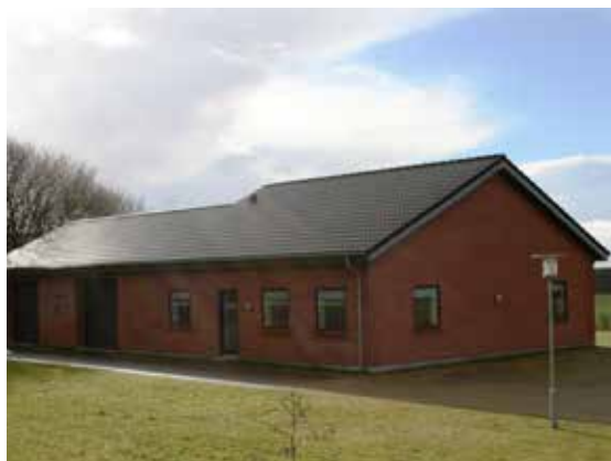
Sabro Vandværk, AnlægsID 80625 og 182669
