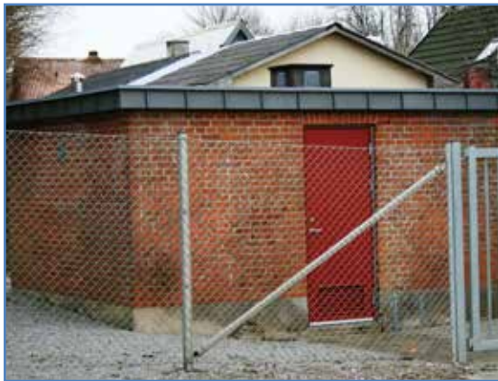
Mejlby Vandværk, AnlægsID 80620
