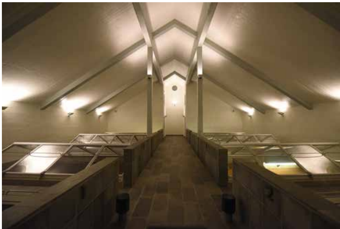
Overdækkede filtre på Åboværket, Aarhus Vand.
