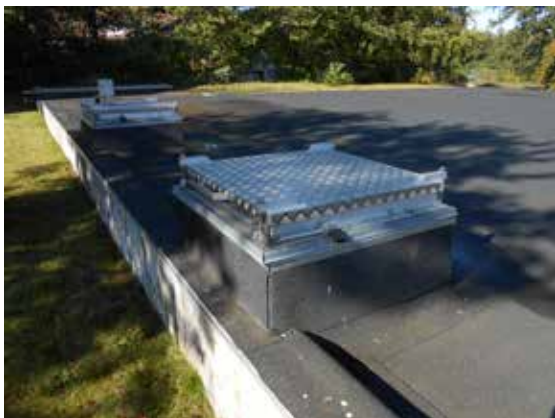
Nedgang til rentvandsbeholder og boringshus
