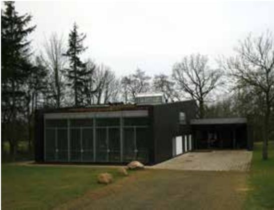
Malling Vandværk, AnlægsID 80618)
