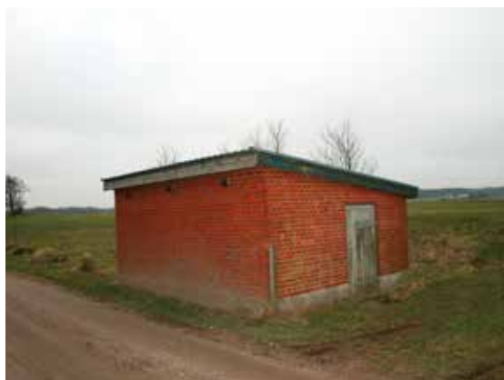
Løjenkær Vandværk, AnlægsID 80647
