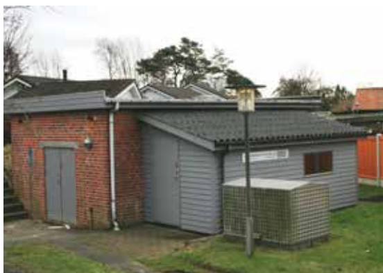
Gl. Hjortshøj Vandværk, AnlægsID 80599
