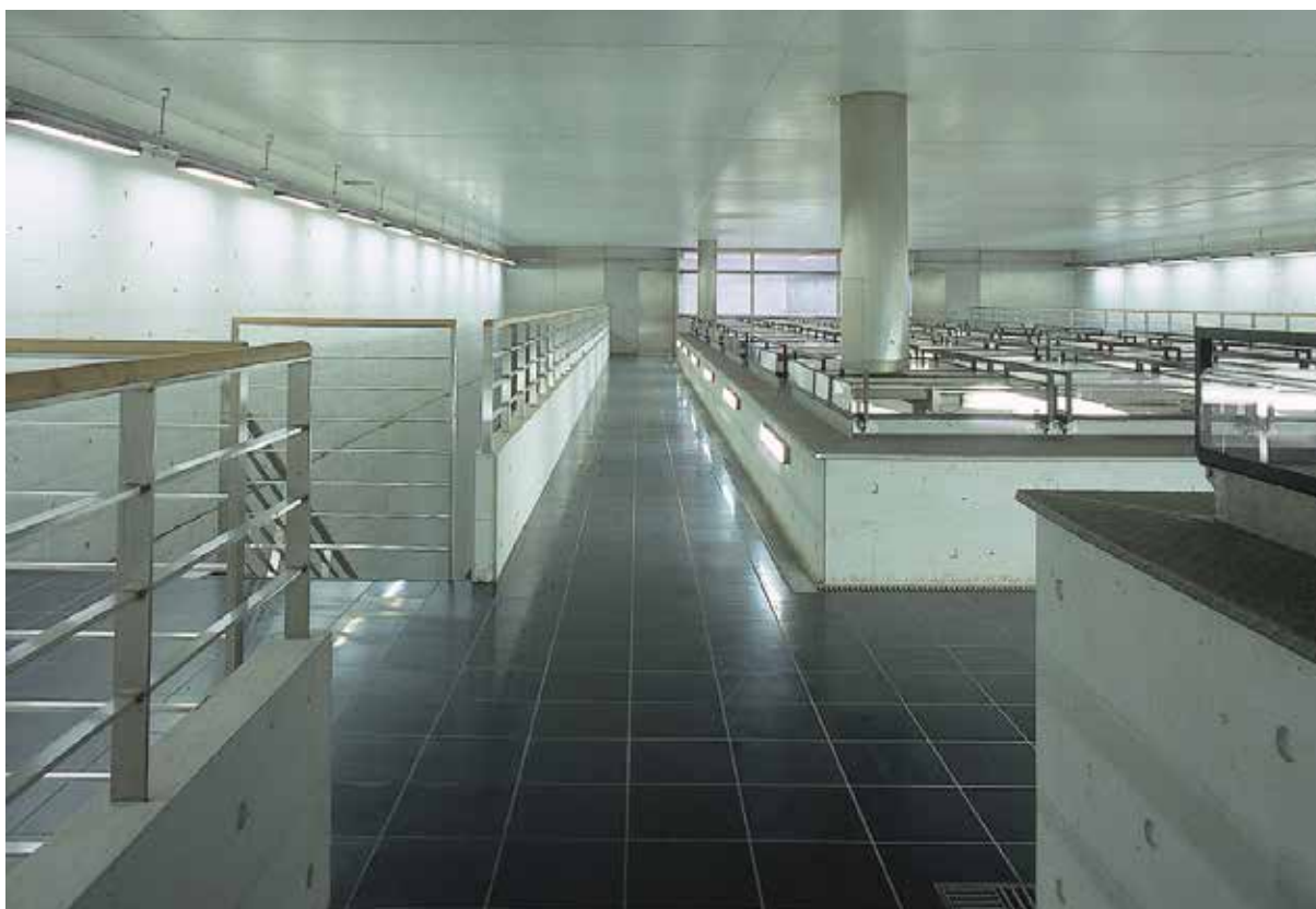
Overdækkede filtre på Østerbyværket, Aarhus Vand.
