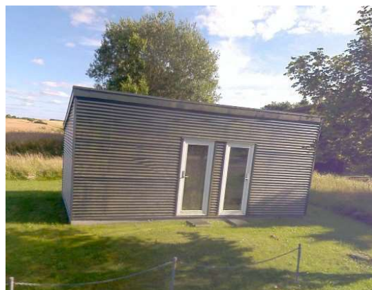
Bygning med pumper og rentvandstank
