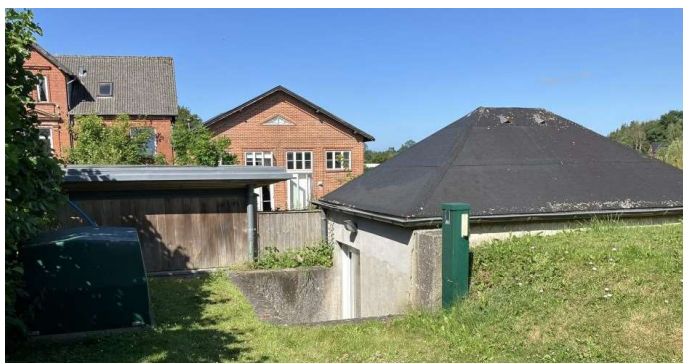
Bygning med filtre
