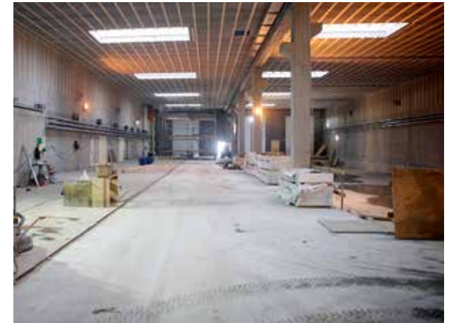
Eksempel fra byggeriet af kontrol- og Vedligeholdelsescentret
