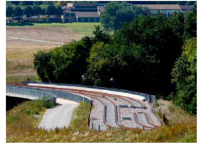
Eksempel på spor med skinner monteret på sveller (Lisbjerg)
