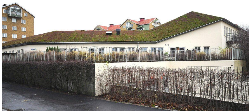
Figur 1.1 Eksempel på bygning med grønt tag.
