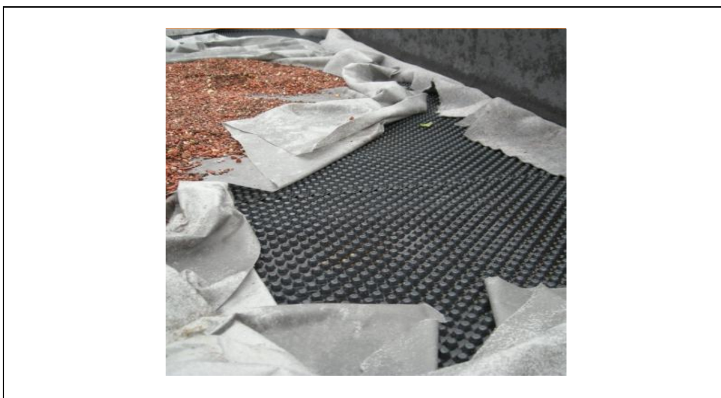
Figur 3.2 Eksempel på opbygning af drænlag.
