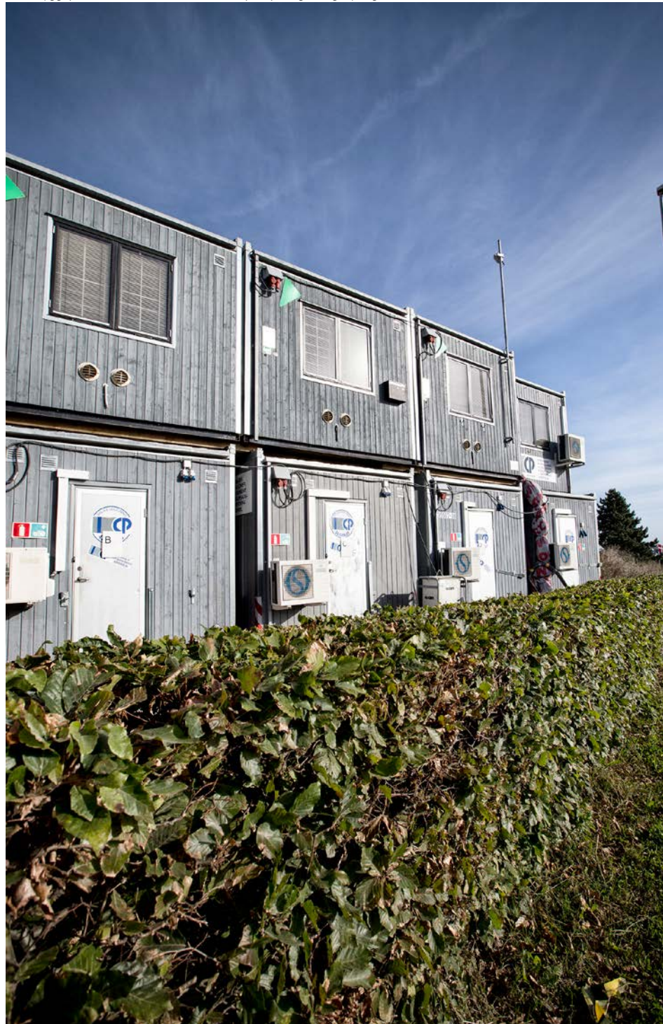
Foto: Byggepladsskure med luft til luftvarmepumper og energistyring.
