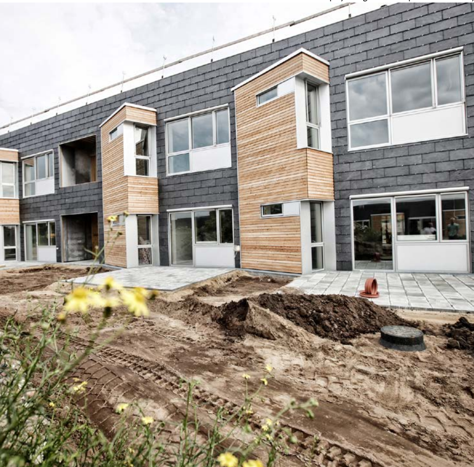
Foto: Præfabrikerede plejeboliger under opførelse Hedevej.
