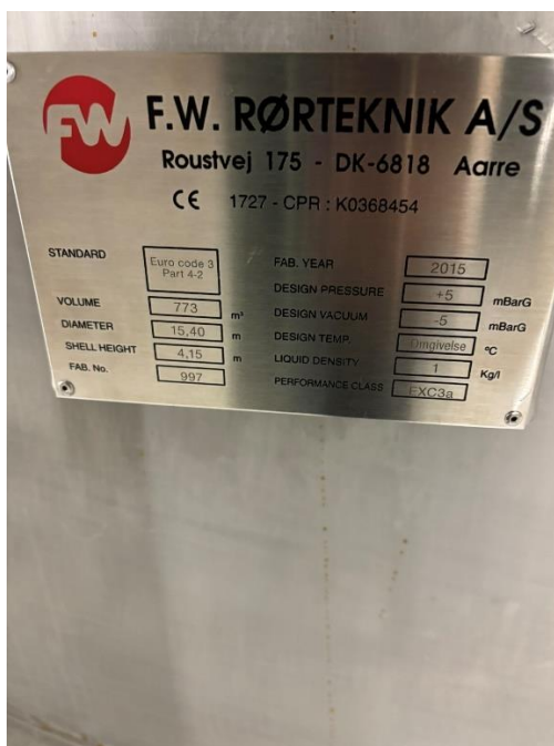
Mærkat på den ene af to stålbeholdere
