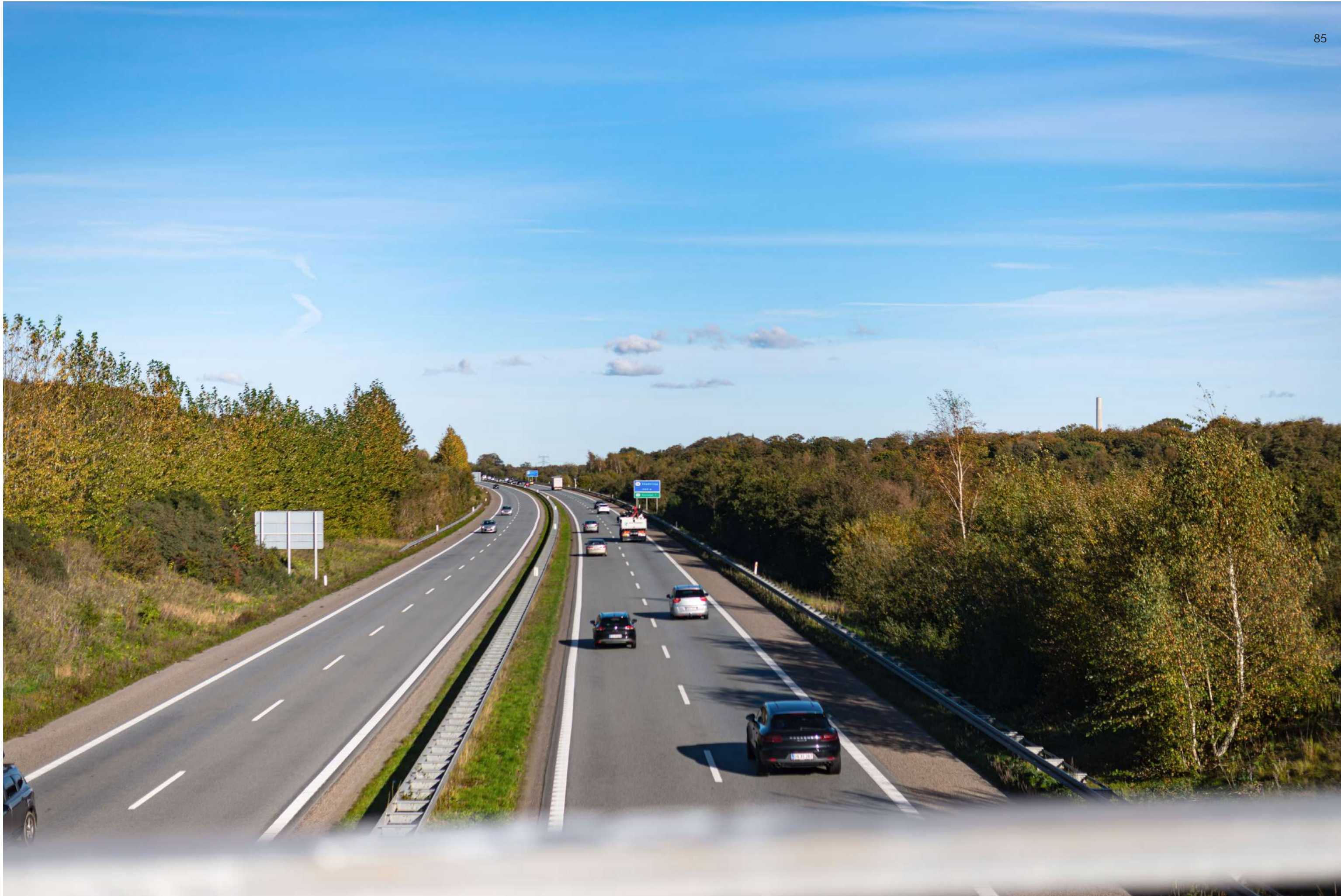
18. Motorvejsbroen ved Hjortshøjvej, mod nordøst, eksisterende forhold
