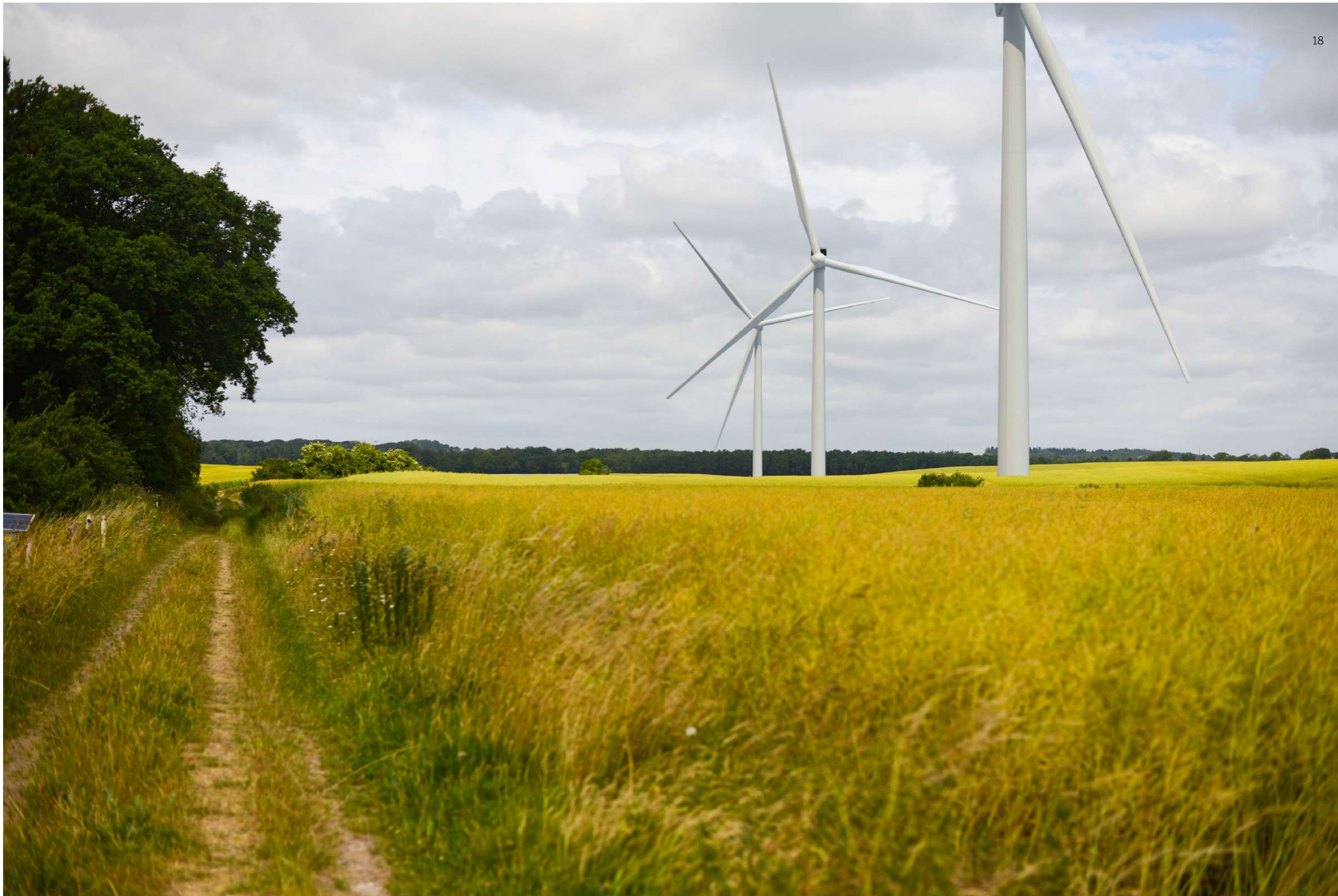
02. Nord på Vosnæs Pynt, mod nord, 3 stk Vestas V136, totalhøjde: 150 m. Afstand til nærmeste vindmølle: 318 m
