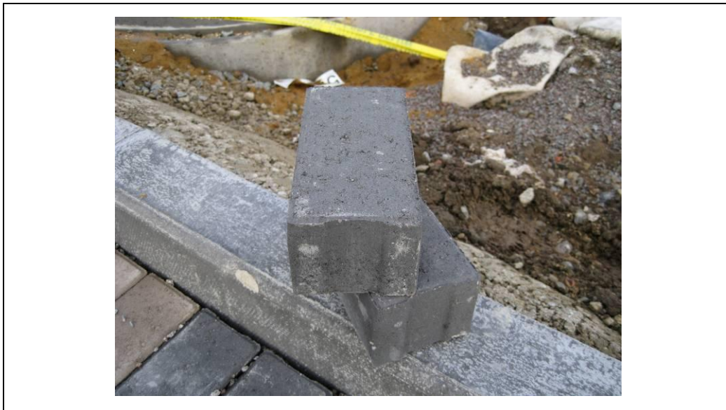
Figur 3.3 Belægningssten med reces til porøs fuge.
