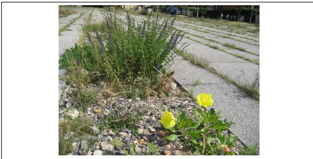
Figur 2.6 Grusbelægning med naturlig vegetation og belægningssten med brede, permeable fuger, der tillader infiltration, Hannover Kronsberg, Tyskland. Foto: A. Backhaus.
