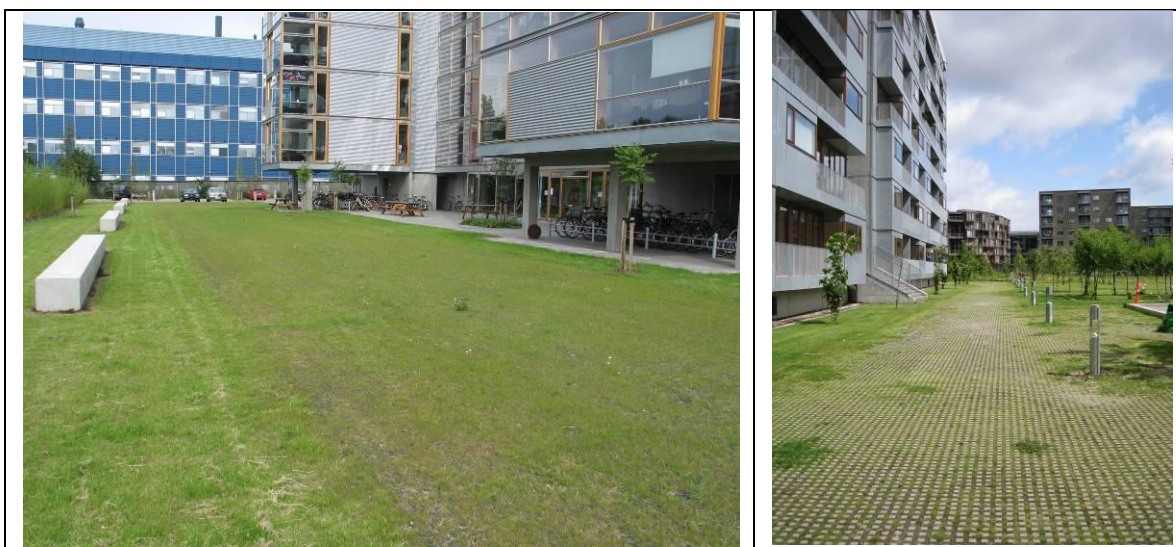
Figur 2.1 Eksempel på græsarmeringsnet Rådmandsgade København og græsarmeringssten, Ørestad.
