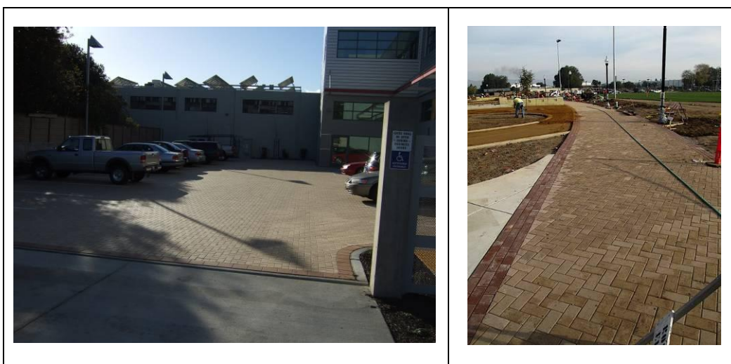
Figur 3.5 Parkeringsareal og sti med permeable belægningssten.
