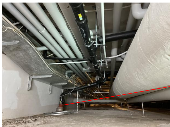
Figur 7.7 Afløbsrør i kælderetagen under køkkenet i parterreetagen.
