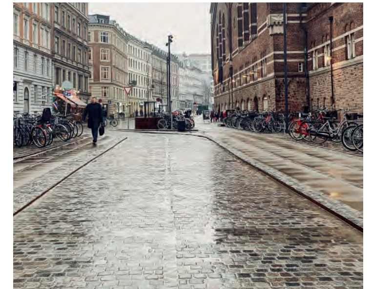
Trafikrum med belægningsflade af jetbrændte/skårne brostensformater på kørebane. Hovedbanen, København.
