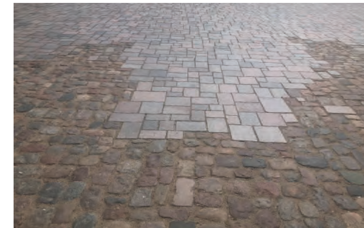
Flettet mønster af belægningssten med forskellige overflader og formater. Bagerst i billedet jetbrændte/skårne granitfliser og forrest gamle huggede brosten og chaussésten.
