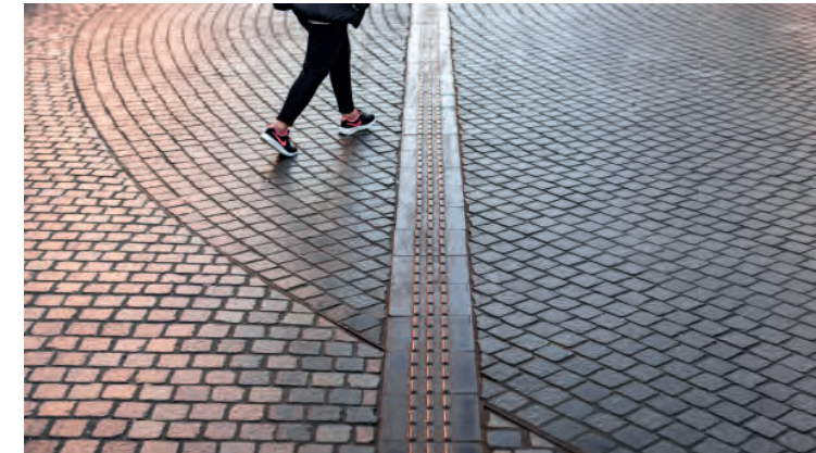
Jetbrændte/skårne chaussésten, der tilgodeser tilgængelighed i de primære ganglinier. Ledelinie i stål nedlagt i belægningsstenen.
