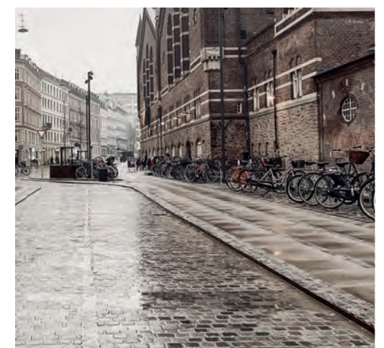
Overgang mellem fortov og kørebanelægning, med kantstensopspring
