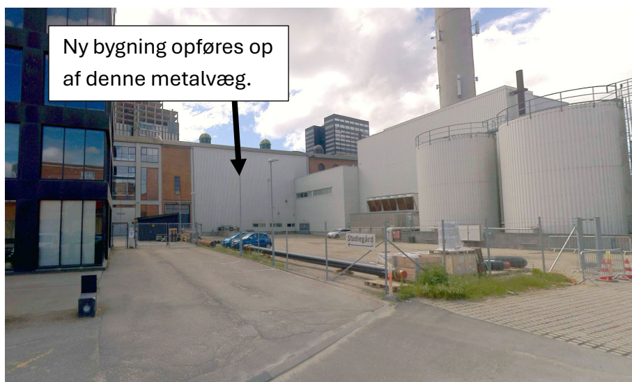
Figur 4. Billede fra bagsiden af den bevaringsværdige bygning set sammen med Aarhusværket.
