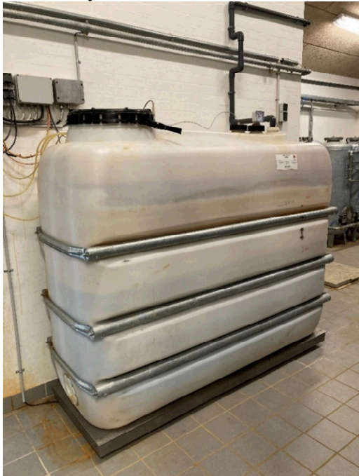
Tilsætningspunkt af jernsulfat i kælderen og inden efterfiltre
