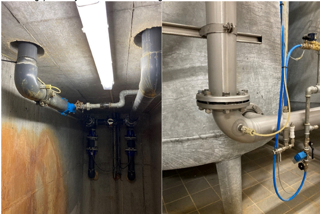
Tilsætningspunkt af jernsulfat i kælderen og inden efterfiltre
