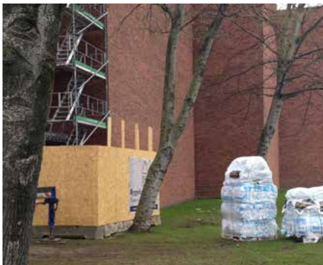
Figur 17: Foto viser, at der i planlægningsfasen ikke er taget højde for, at der skal etableres en beskyttelseszone, hvor der ikke må stå materialer eller inventar.
