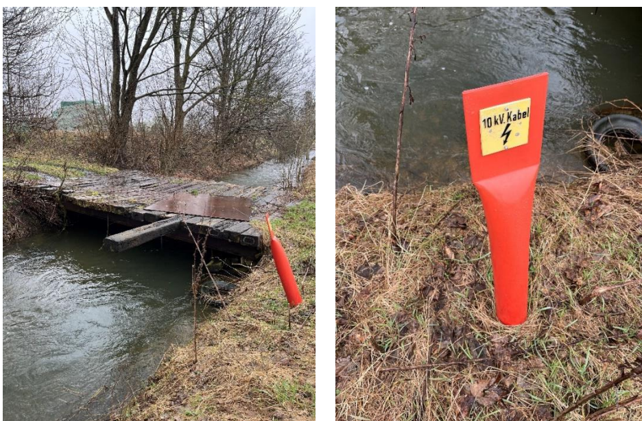
Figur 4-9: Foto af bro (st. 3.139) og markering af krydsende 10 kV. kabel.
