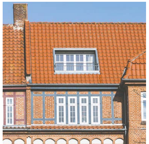
Foto: Tagterrasse. Størrelsen på udskæringen i taget tilpasset tagfladen og facadens vinduespartier.
