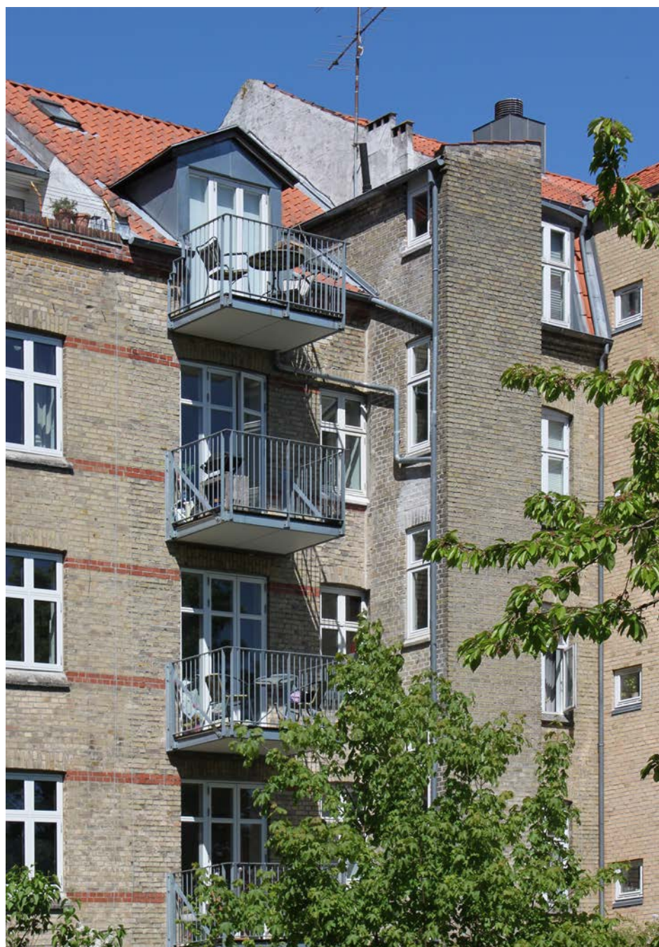
Foto: Gårdfacader med bl.a. mansardkviste, kvistaltaner og indeliggende tagterrasser
