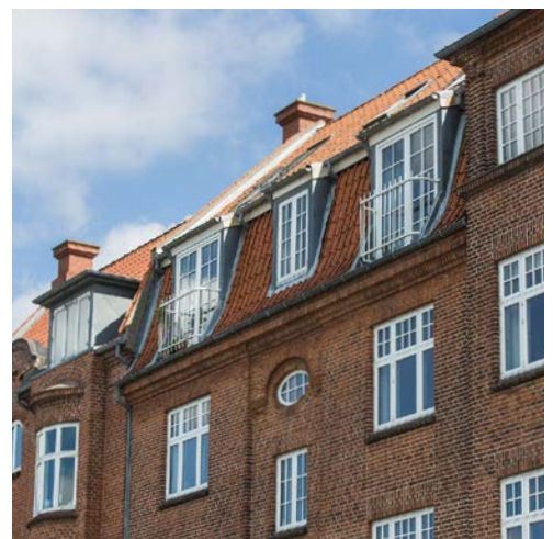
Foto: Kvistaltaner i mansardetagen med rækværk bag facadeflugten.
