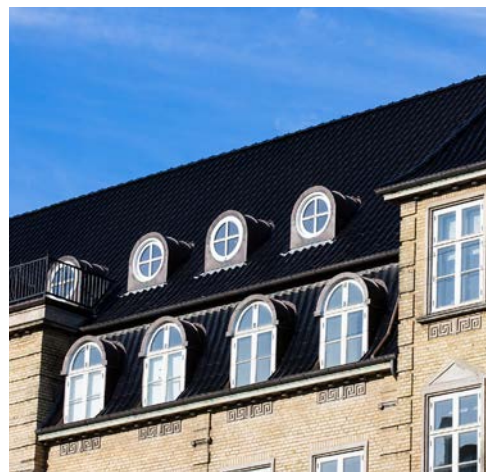
Foto: Medaljonkviste i tagetagen over mansardtage understreger den hierarkiske opbygning af facaden.
