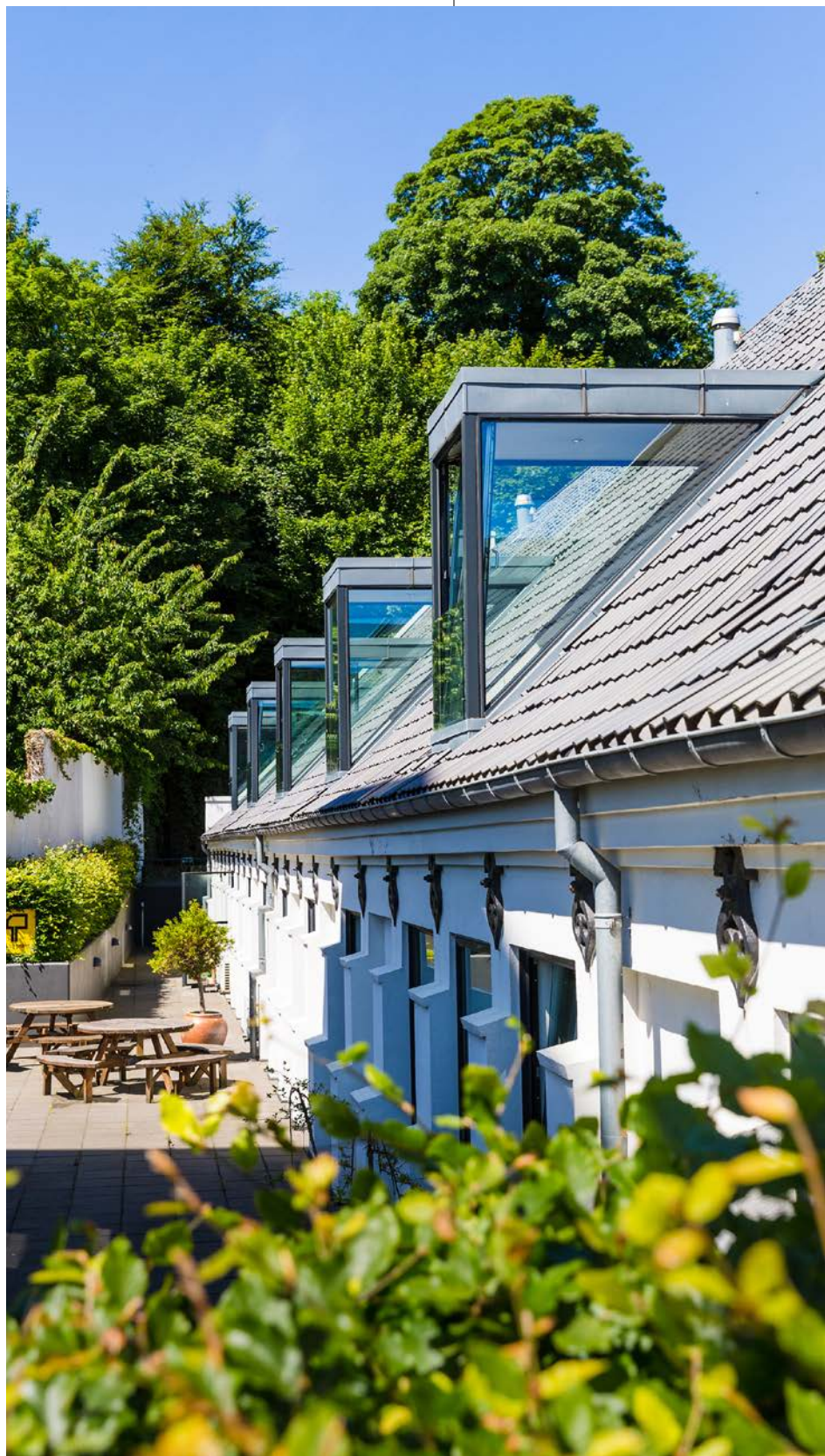
Foto: Glas i kvistflunkene kan give en historiske bygning lethed og transparens på langs af taget.
