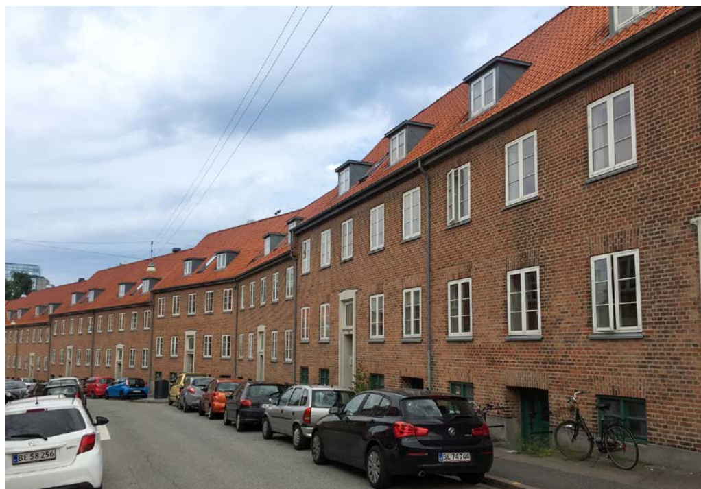
Foto: Kviste med smalle flunke og tagkonstruktion.
