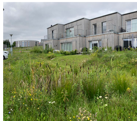
Figur 6.10. Almene boliger, Lauritshøj, Skødstrup. Overfladevandet ledes langs privathaverne via små render og videre over i grøfter, der bevæger sig med terrænet og ender i udposninger på grøfter eller i regnvandssøer.
