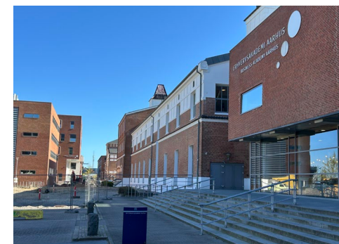
Figur 2.7. FDB (Fællesforeningen for Danmarks Brugsforeninger) opførte i starten af 1900-tallet et fabriksanlæg i Viby J, tæt på jernbanen. Fra midten af 1970'erne og frem til 1990 blev produktionerne langsomt afviklet. Fra ca. år 2000 er de gamle fabriksbygninger gradvist blevet omdannet til et erhvervs- og institutionsområde. Der er tilføjet nye bygninger, der primært er opført i røde teglsten, som de oprindelige bygninger.
