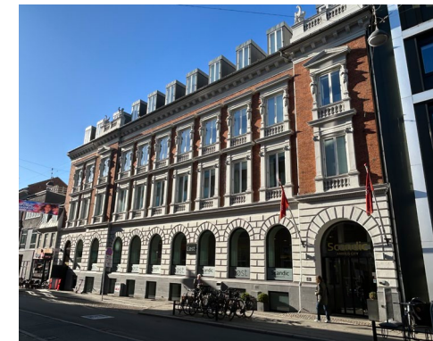
Figur 2.10. Et eksempel på bevarelse af en facade. Østergades Hotel i Aarhus C blev opført i Aarhus i 1875. Den karakteristiske facade præger endnu gadebilledet, hvormed den oplevede arkitektoniske kvalitet er fastholdt. Resten af bygningen blev revet ned i 2010 og erstattet af et nyt hotel, der også strækker sig over naboarealerne. Den oprindelige facade er bevaret, renoveret og integreret i det nye hotel.
