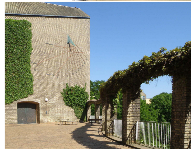
Figur 4.9. Aarhus Universitet er opført med gule teglsten. Det samme er tilfældet med senere bygninger for at tilpasse sig Universitetets kontekst. Mange facader er tilgroet med vedbend, hvilket forstærker sammenhængen med det omkringliggende grønne parklandskab.
