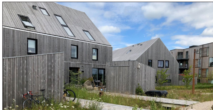
Figur 4.7. Rækkehuse i Nye ved Aarhus opført i træ. Bygningernes Co 2 e-aftryk er forholdsvis lavt, da der er anvendt løsninger og materialer med lavt energiforbrug i fremstillingen. Bygningerne er desuden designet for adskillelse.
