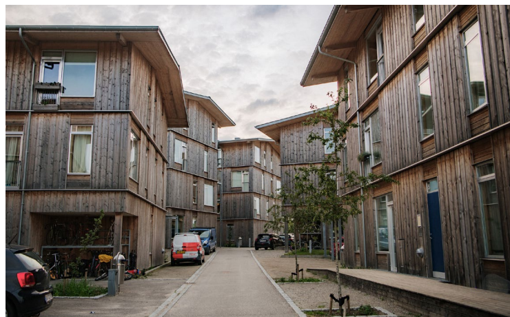
Figur 4.8. Lisbjerg Bakke er opført i træ. Der er anvendt en hybrid byggeteknik og et særligt søjlebjælkesystem, der giver høj planmæssig fleksibilitet og understøtter fremtidig demontering og genbrug af byggematerialer.
