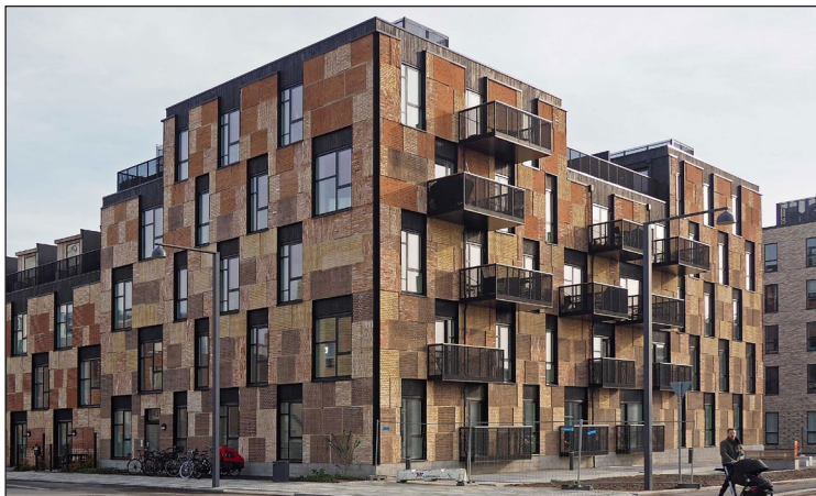
Figur 4.2. Ressourcerækkerne i Ørestaden. Bebyggelsens facade er opbygget af udskårne elementer af cementfugt murværk fra 60'erne og 70'erne, som normalt ikke kan genbruges, da murstenene ikke kan skilles ad enkeltvis. Stenene stammer fra bl.a. fra Carlsbergs historiske bryggerier samt fra gamle skoler og industribygninger rundt omkring i Danmark.
