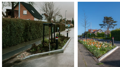
Figur 6.9. Flere steder i Aarhus er der etableret vejbede, som forsinket regnvandet og aflaster kloaksystemet. Samtidig fungerer vejbedene som fartdæmpere på vejene (Se også figur 1.8 nr. C).
