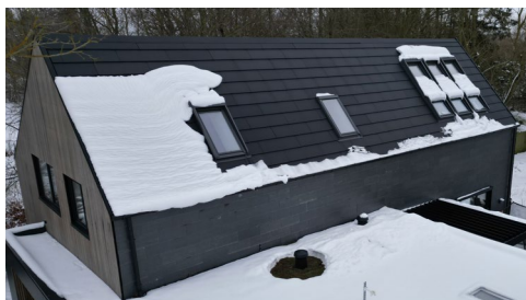
Figur 6.6. Eksempel på solceller, der er integreret i tagmaterialet. De to tagflader - med og uden solceller - ser ens ud.
