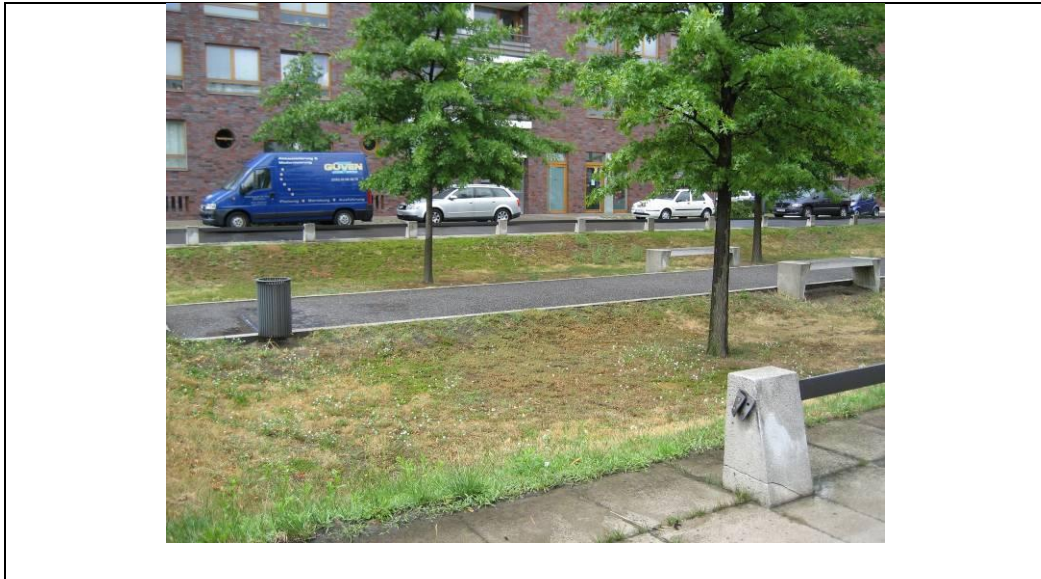
Figur 2.4 Grøfter afskærmet med pullerter langs mindre befærdet vej.
