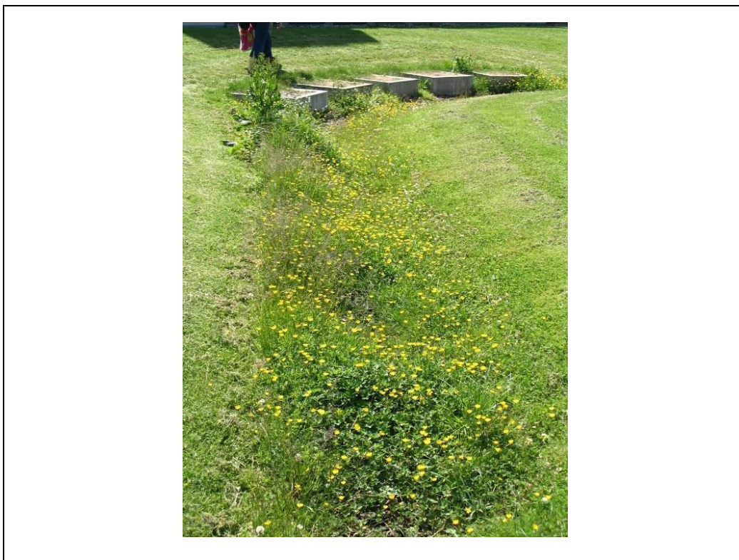
Figur 2.3 Rende med blomster i bunden og trædesten, der også forsinker vandet.
