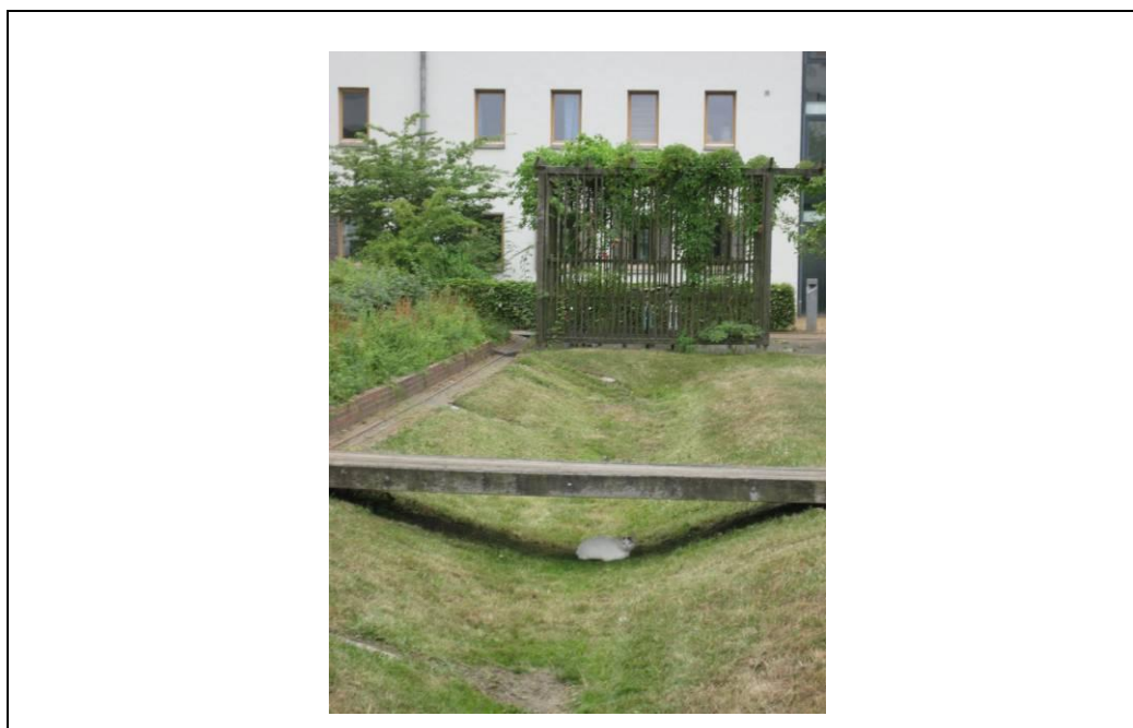
Figur 2.5 Eksempel på grøft.
