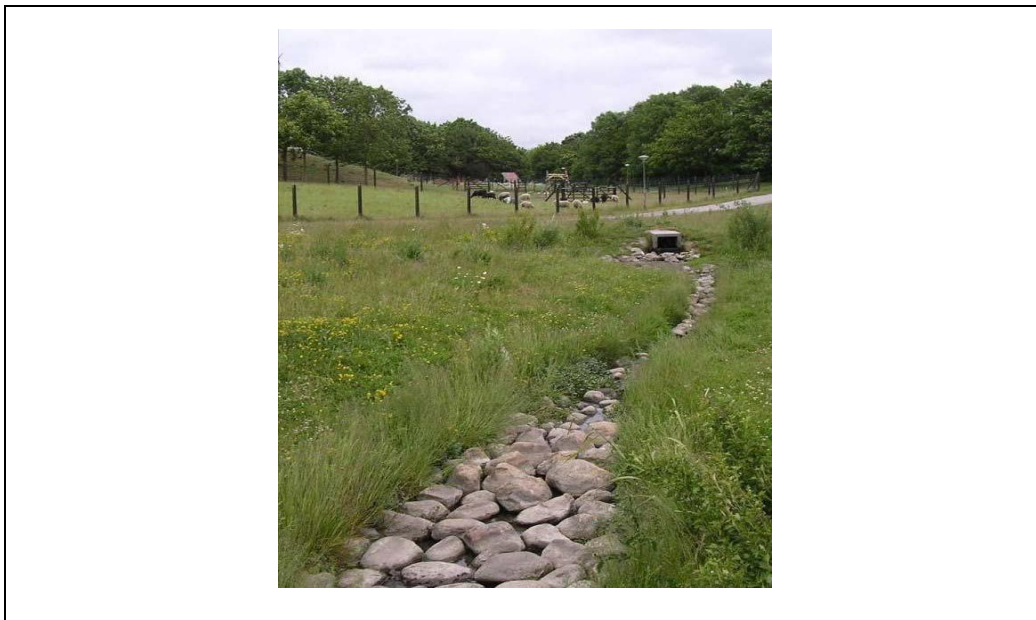
Figur 2.1 Grøft med store sten i bunden, som forsinke og ilter vandet samt øger nedsivningen.
