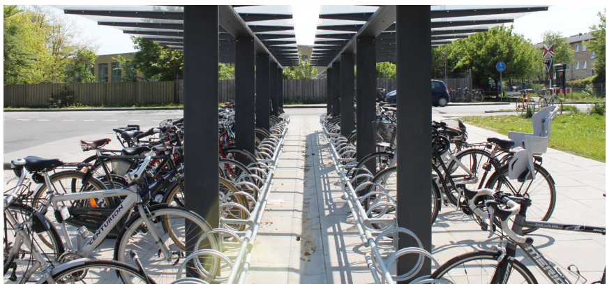
Ved parkering over længere tid tilbydes overdækning som her ved busholdeplads i Aarhus.
