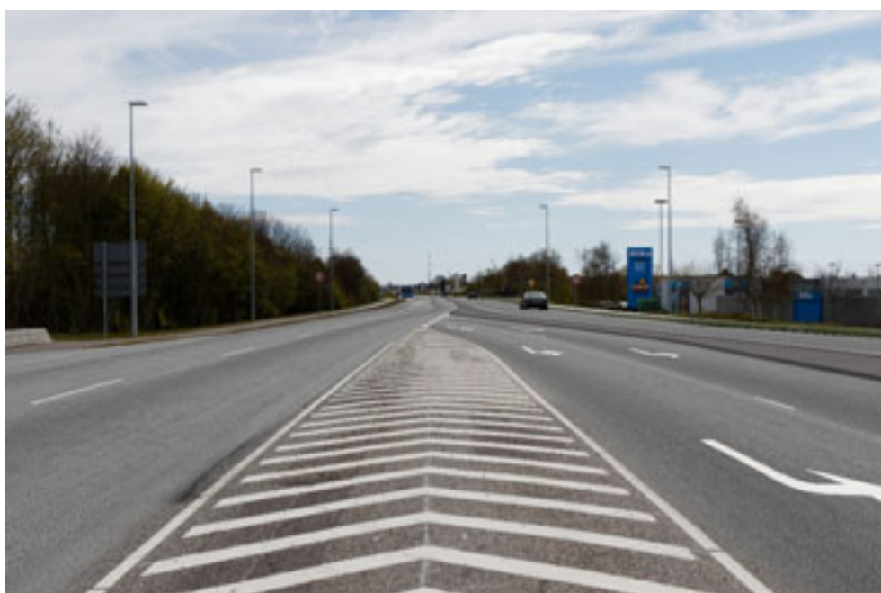
Figur 8.7 Udbygget Viborgvej med 1m bred befæstet midterhelle set mod øst ved Tilst Skolevej / Anelystvej. Nuværende udformning er vist i det øverste billede.
