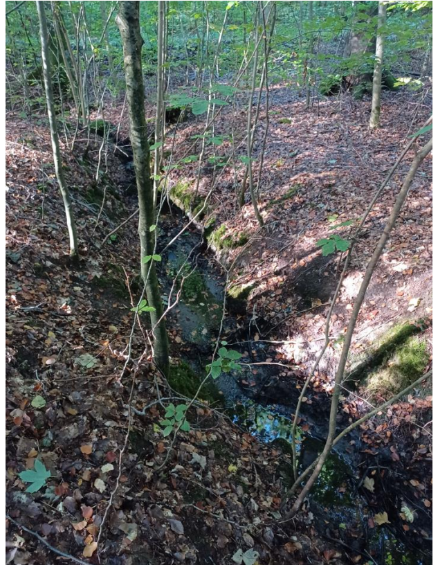
Foto 18. VI. Nord for Borgmesterhøj, nedstrøms sti underføring mod stranden
