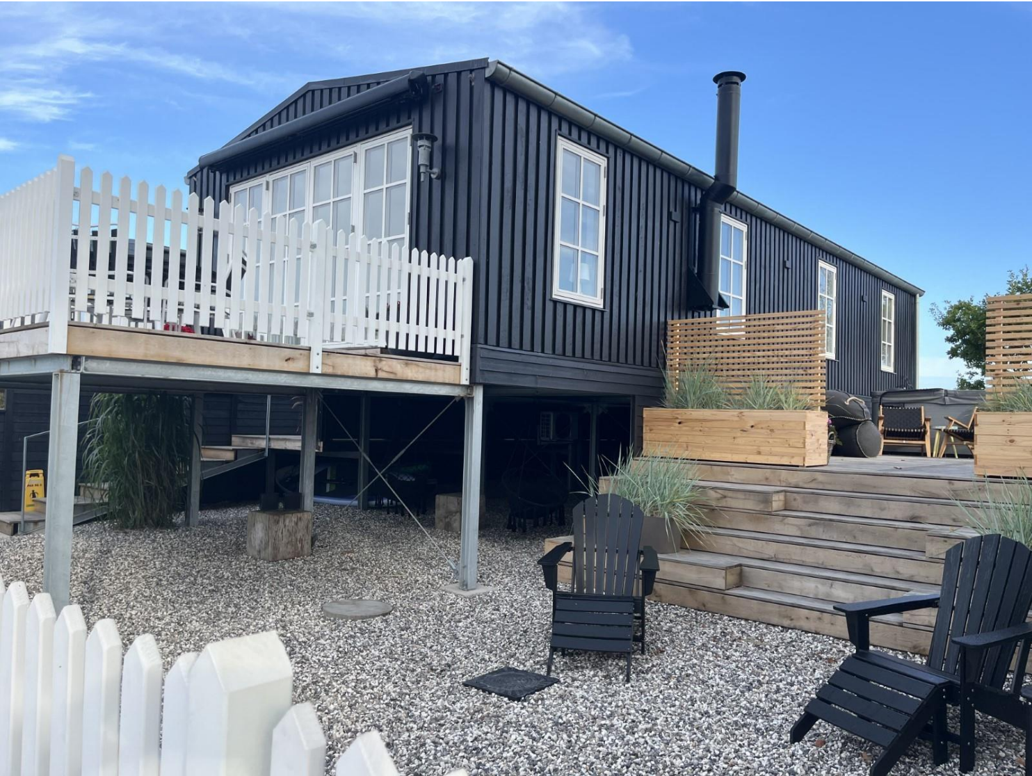
Foto: Anja Wejs Billedet er fra Moshusevej ved Bjert Strand syd for Kolding. En række sommerhuse er hævet op på pæle som alternativ til at bygge et dige. Herved kan sommerhusene i perioder tåle at blive oversvømmet.
