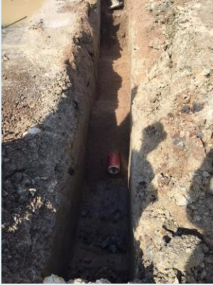
Eksempel på etablering af forsinkelsesvolumen i form af regnvandsbassin (tv.) samt etablering af omfangsdræn (th.) Fotos: NIRAS
