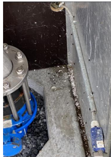
DGU. nr. 79.1502 Flamingorester fra isolering falder ud fra låget, evt. pga. insekter i overbygningen
