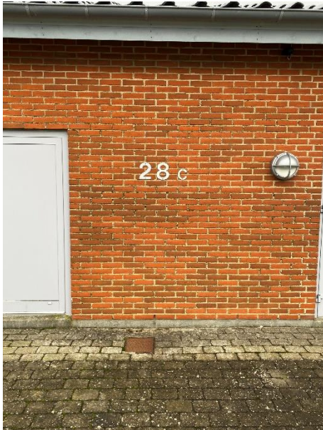
Vorrevej 28C indgang vandværksbygning (billede fra 2021)
