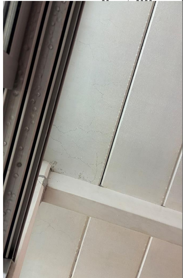
Loft i filtersal. Opbygning af loft – beton elementer forbandt.
