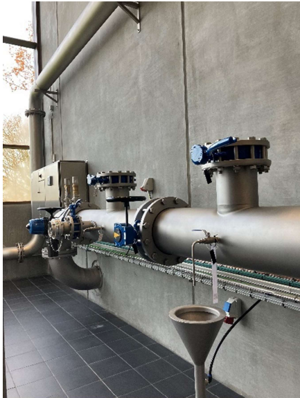
Prøvehane afgang vandværk, rør forberedt til UV samt overløb fra tank øverst i billedet
