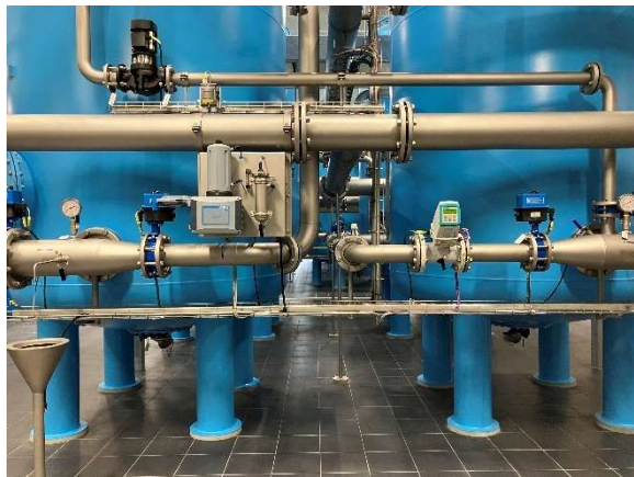
Filterlinje uden kobbertilsætning
