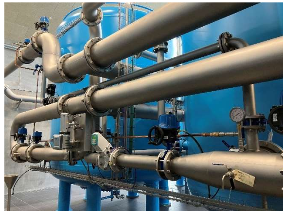
Filterlinje med kobbertilsætning
