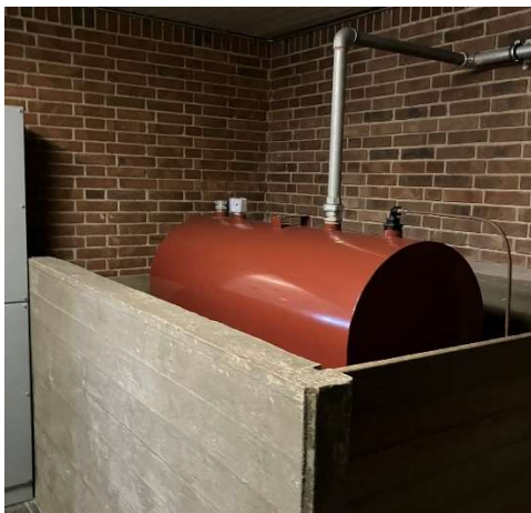
B8: Dieselmotor til nødgenerator
