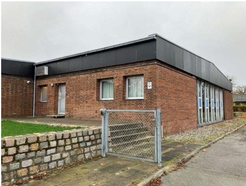
B1: Bygningen omkring beholderen set forfra. Indhegningen er brudt, da hækken er fjernet.
