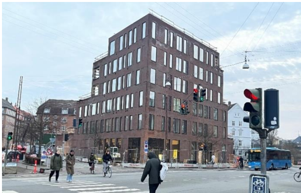
Facade mod Thorvaldsensgade/Vestergade (mod syd/vest)
