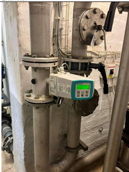
Måler og prøvehane afgang vandværk
