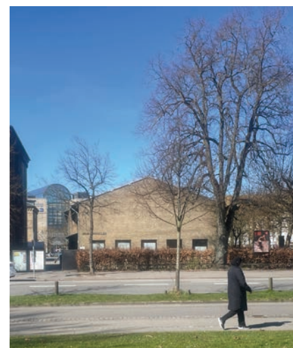
Bygning C - Facade mod Rådhusparken
