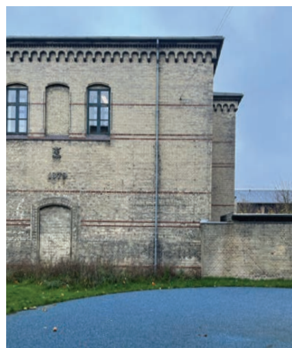
Bygning B - Facade mod Skt. Nicolaus Gade
