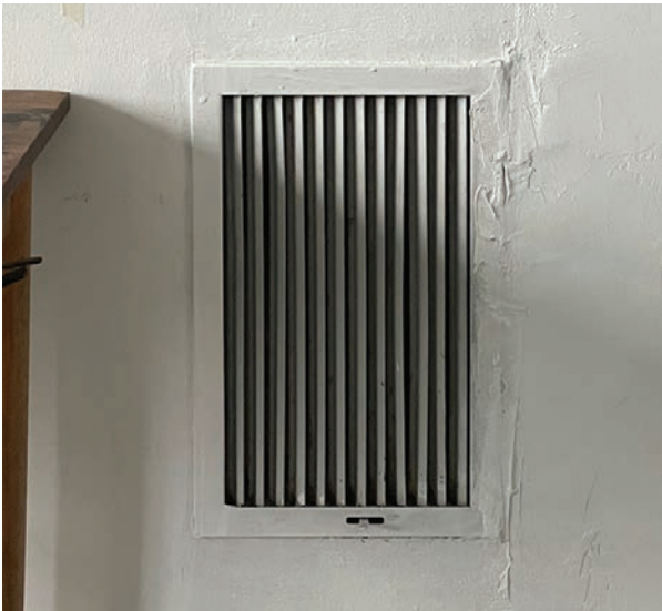
Bygningundersøgelser - Eksisterende kanaler og hulrum
