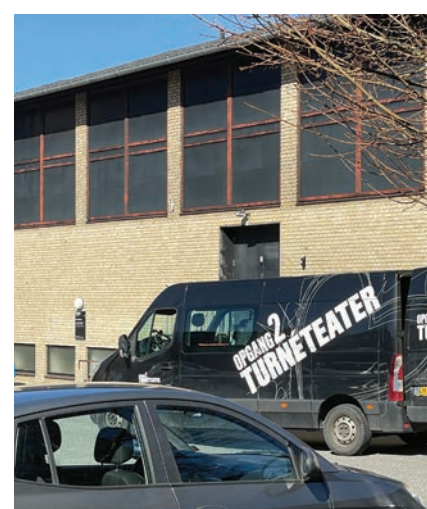
Bygning C - Facade mod gården
