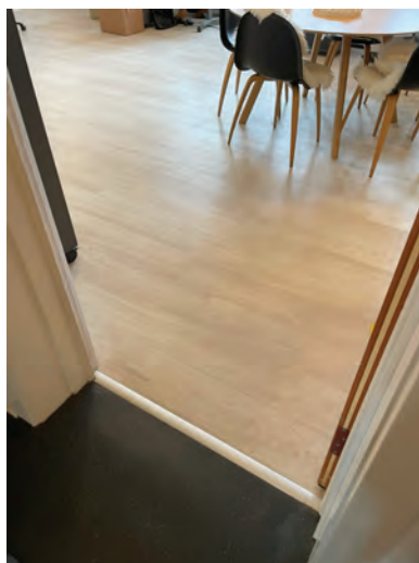
Gulv på etageadskillelse med parketgulv og linoleum
