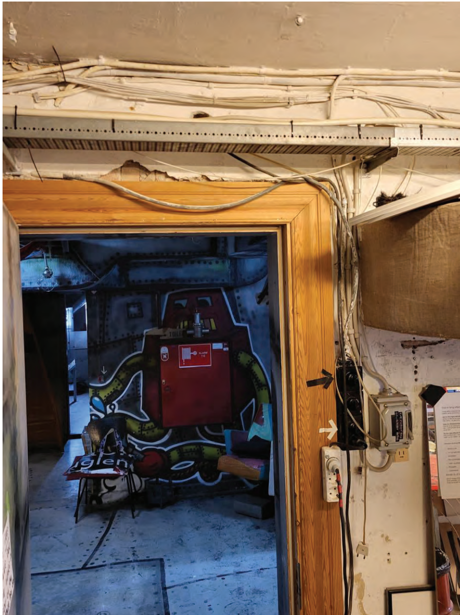
Foto 9 - elinstallation i kælder bygn. B
