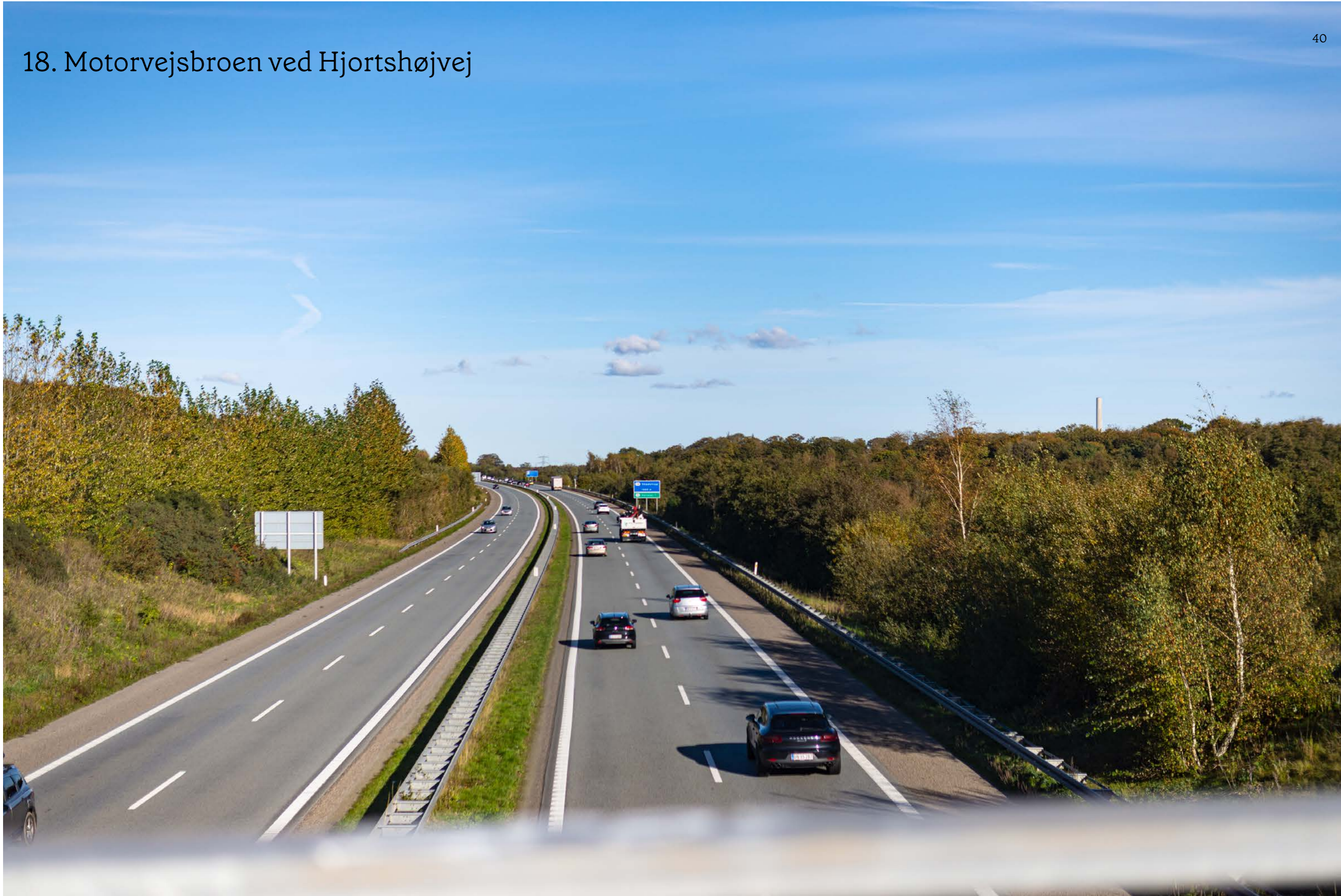
18. Motorvejsbroen ved Hjortshøjvej, mod nordøst, eksisterende forhold
