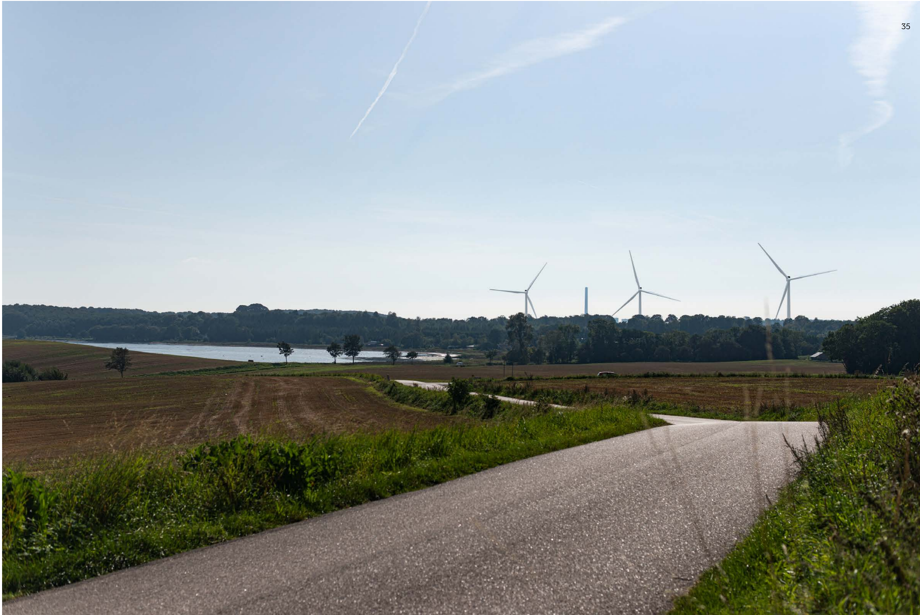
15. Gamle Løgtvej 8, mod sydvest, 3 stk Vestas V136, totalhøjde: 150 m
