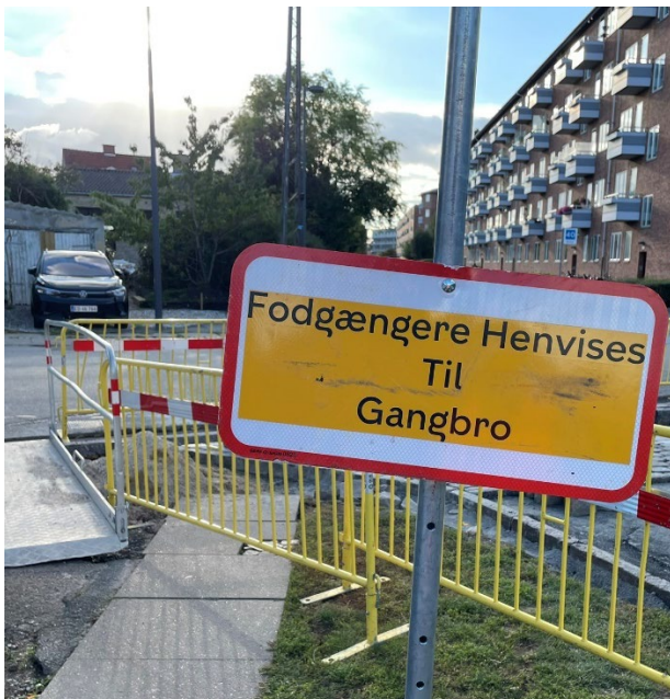
Billede 10: Fodgængervinkel af vejarbejde fra Palermovej fra øst med skilt "Fodgængere Henvises Til Gangbro"
