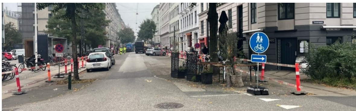
Billede 31: Fodgængervinkel af vejarbejdet. Viser Nansensgade fra sydvest med skilt om fællessti til højre.
