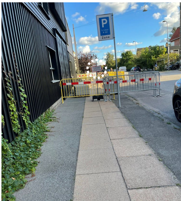
Billede 8: Fodgængervinkel af vejarbejde fra Strandlodsvej fra nord med skilt "Fodgængere henvises til modsatte fortov" (markeret med stiplede hvide cirkler)
