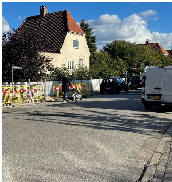
Billede 11: Fodgængervinkel af vejarbejde fra Palermovej/Strandlodsvej fra vest fra fortov overfor fortovet med vejarbejde
