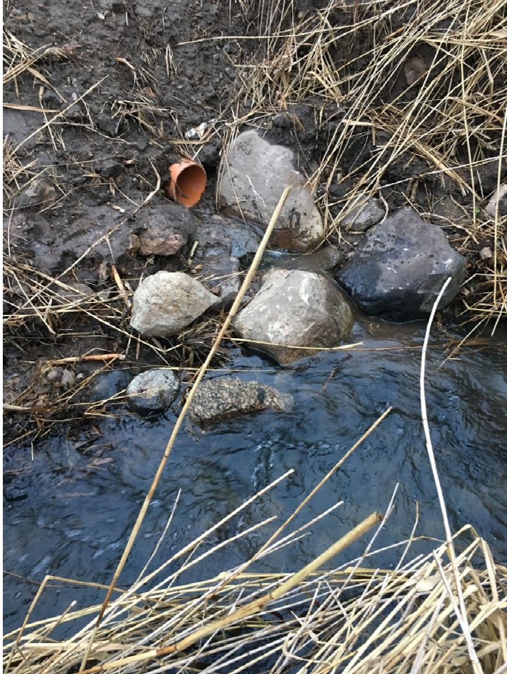
Figur 4. Udløbet skal etableres så højt som muligt i brinken, ved stenkastning (fraktion hånd-sten til kampesten), så den største del af energien tages op af vandet inden det når ud i vandløbet, og erosion af vandløbets sider undgås
