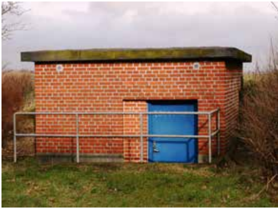
Lillering Vandværk, AnlægsID 80615
