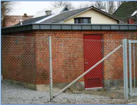
Mejlby Vandværk, AnlægsID 80620
