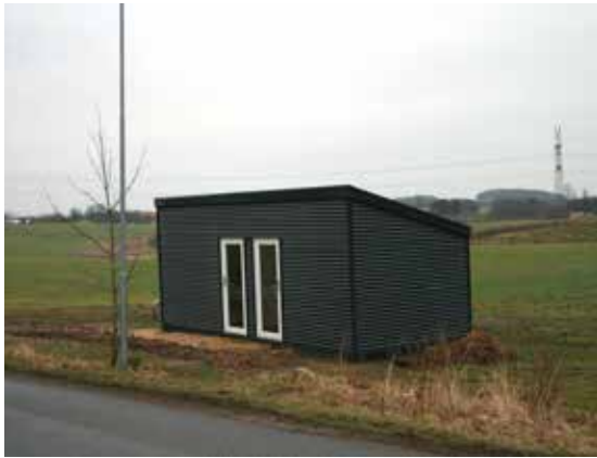
Ask Store Vandværk, AnlægsID 80639
