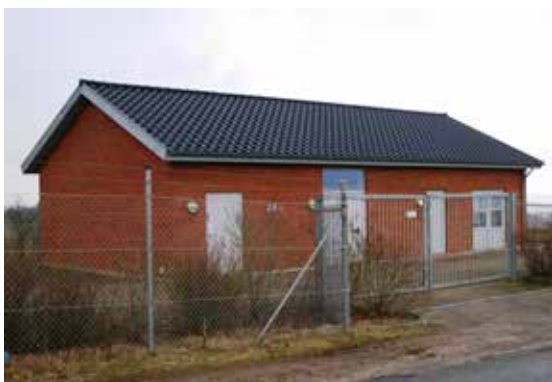
Løgten-Skødstrup Vandværk, Vorrevej 28, AnlægsID 183030 og 183031
