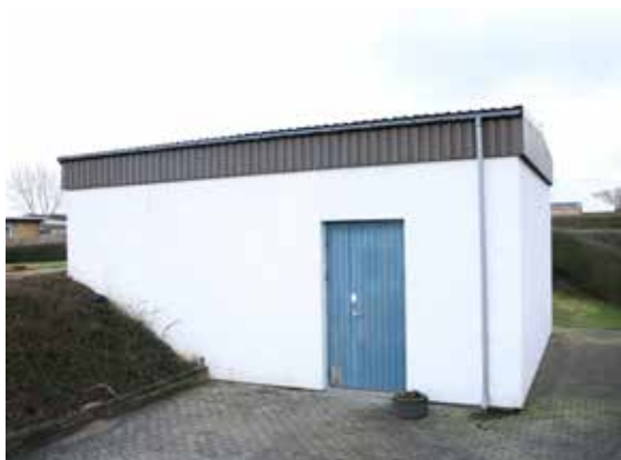
Studstrup Vand, AnlægsID 80634
