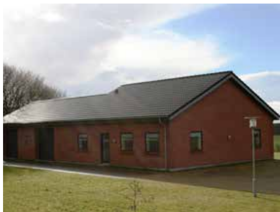
Sabro Vandværk, AnlægsID 80625 og 182669
