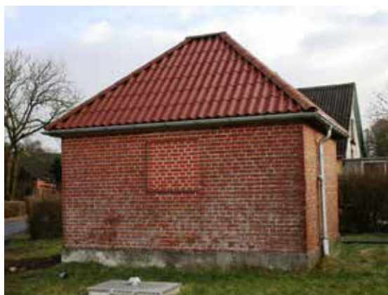
Hvilsted Vandværk, AnlægsID 80607
