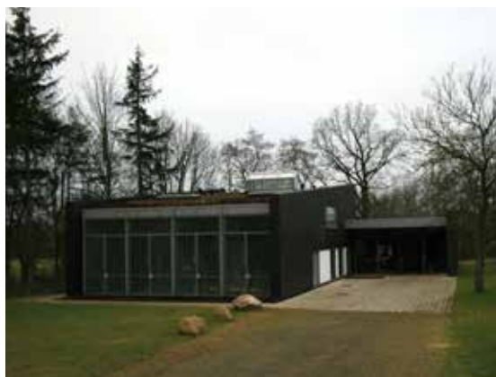
Malling Vandværk, AnlægsID 80618)
