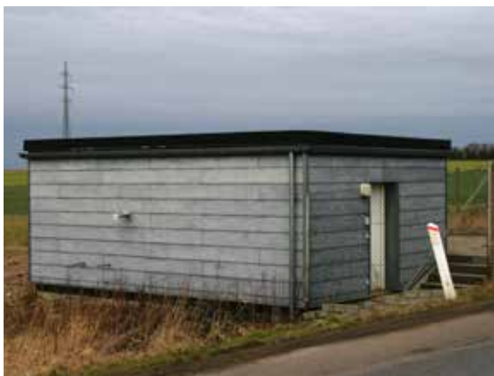
Hårup Vandværk, AnlægsID 80611
