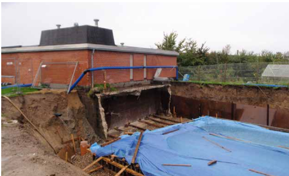
Solbjerg Vandværks renovering af rentvandsbeholder.
