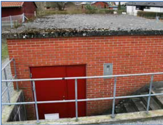
Mejlby Vandværk, Helbovej, AnlægsID 80621
