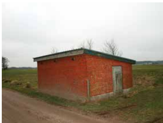
Løjenkær Vandværk, AnlægsID 80647
