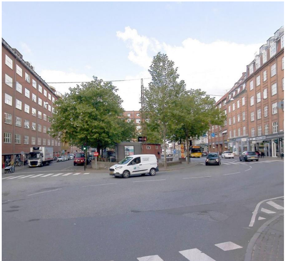
Figur 1 Vesterbro Torv set mod vest ved Vesterport/Langelandsgade.
