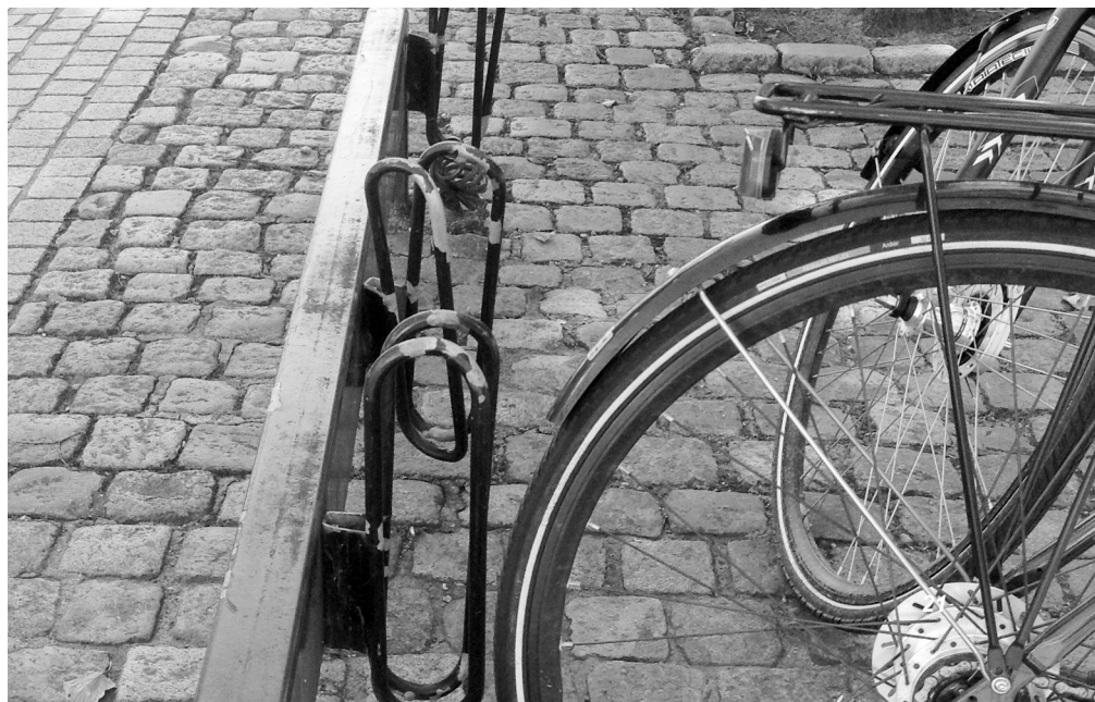
Defekt cykelstativ der bør repareres inden for kort tid.
