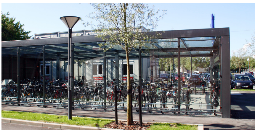
Cykelparkering ved arbejdsplads, hvor der er overdækning med høj grad af gennemsigtighed.
