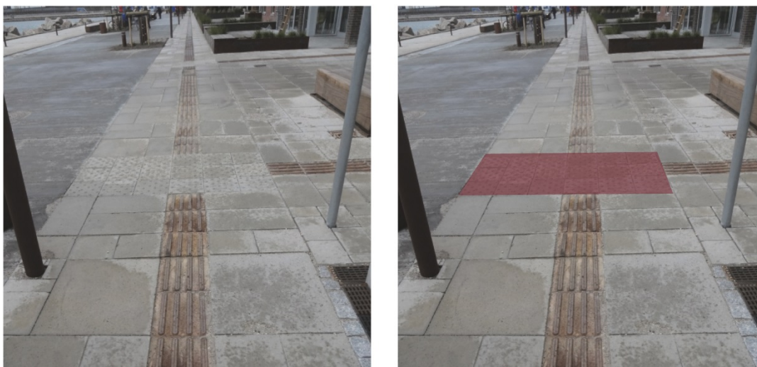
Figur 2.6 Støbejernsledelinje. Til højre forbedringsforslag, hvor der også er farvekontrast i opmærksomhedsfeltet.
