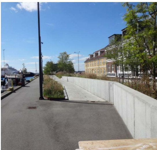
Figur 5.2 Rampeanlæg i Fredericia C, Fredericia Kommune
