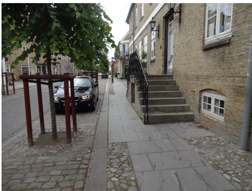
Figur 1.7 Lindegade, Christiansfeld. Bemærk løsning ved trappesten, hvor den jævne belægning trækkes udenom trappen. Kørestolsbrugere kan her sætte det yderste hjul ud på den brede kantsten.
