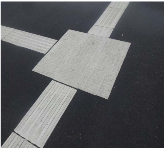
Figur 2.8 Nærbillede af taktilelementer.
