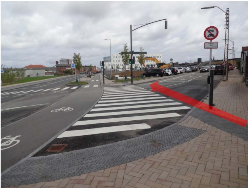
Figur 3.4 Ejlskovsgade - Kottesgade, Odense Kommune. Gangretningen for retningsfeltet fremhævet
