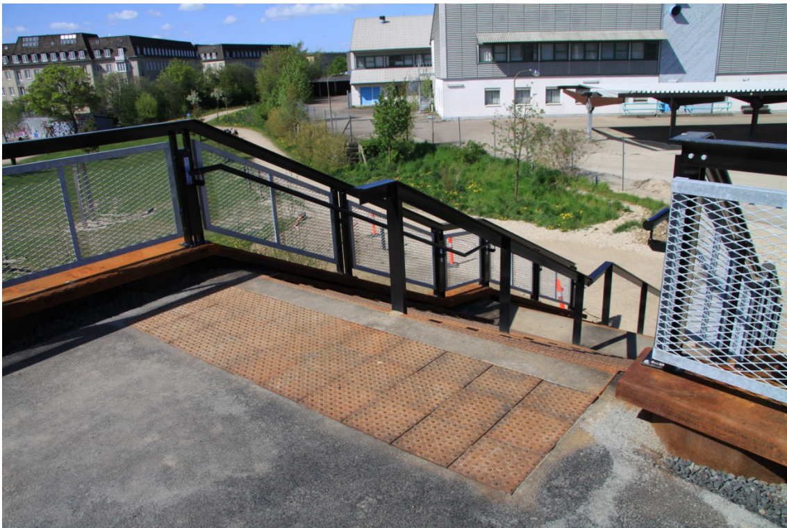
Figur 5.3 Trappeanlæg ved bro over metroen, Frederiksberg Kommune
