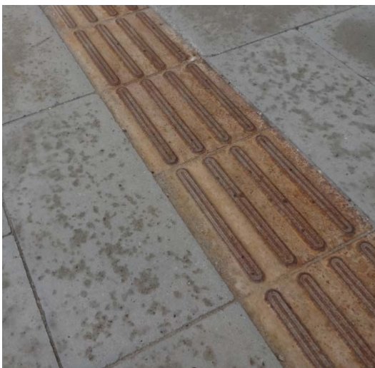
Figur 2.5 Nærbillede af støbejernsledelinje
