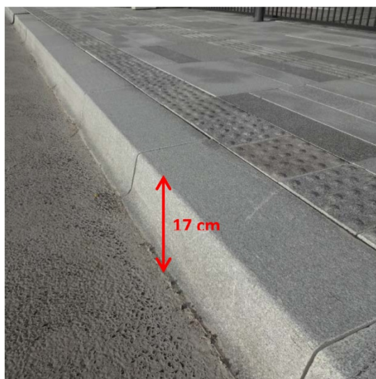
Figur 4.2 17 cm kantsten ved Nørre Campus
