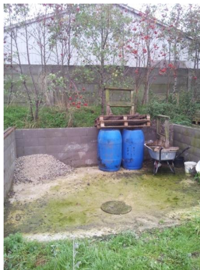
Figur 4.2. Vaskeplads med afløb til gyllesystem.
