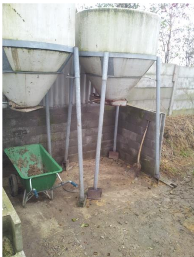
Figur 4.1. Fodersiloer på befæstet areal, som har afløb til gyllesystem.
